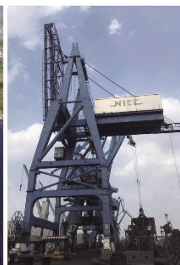
世界第一台集装箱吊机设备
